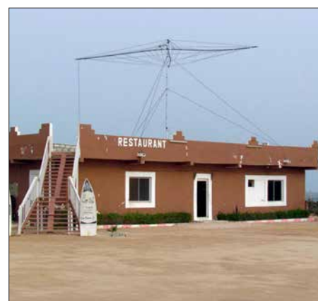
Dank der Treppe hatten wir einfachen und schnellen Zugang zum Dach.
