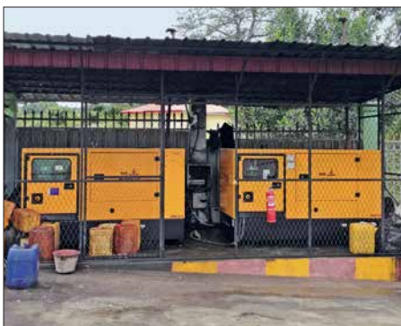
36-kW-Generatoren des Hotels auf Bioko
