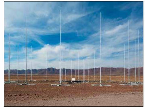
24 Detektive stehen im Kreis: Peilanlage für 1 MHz bis 30 MHz in Namibia. Sie ermittelt Richtungen mit besser als 1° Genauigkeit.
