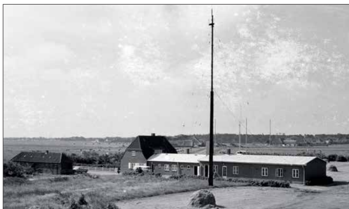
Das unscheinbare Betriebsgebäude der Beobachtungs- und Peilfunkstelle Sankt Peter-Ording Ende der 1960er-Jahre. Im Vordergrund die Sendeantenne, im Hintergrund sind die Vertikalantennen der Adcock-Peilanlage zu sehen.
