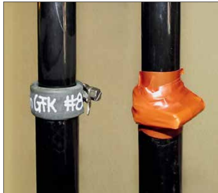
Bild 39: Montierte Schelle (links), mit Klebeband umwickelt (rechts)
