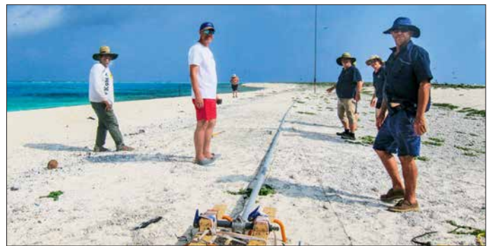
Das VK9MA-Team beim Aufstellen der 160-m-Vertikal mit der selbstgebauten Basis
