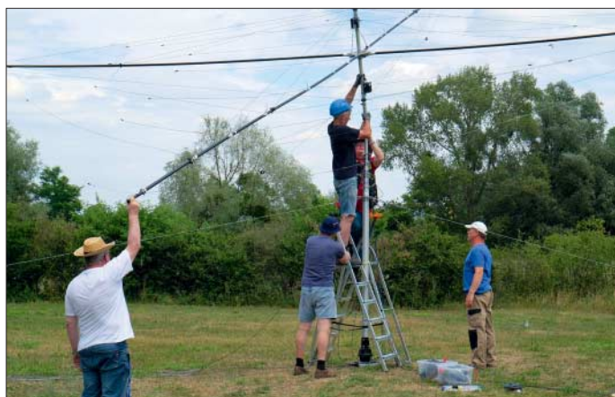
Antennenteam bei der Arbeit
