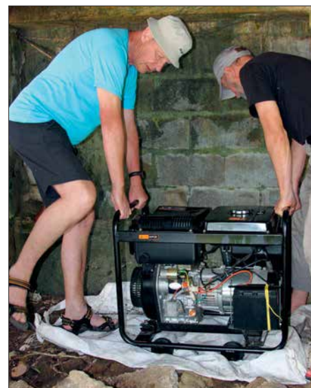
Der für die DXpedition angeschaffte 5,5-kW-Generator versorgte uns zuverlässig.
