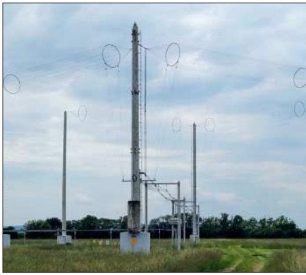
Bild 3: Typische Doppel-Quadrantantenne für die Rundfunkbänder 5, 6, 7 und 9 MHz Foto: Ulrich Eitler (CC BY-SA 4.0)
