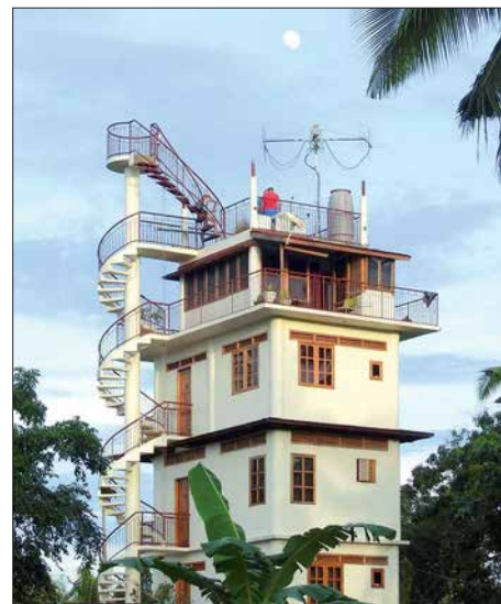
Oben im Turmzimmer befand sich das DX7EME-Shack. Die Antennen hatten freie Sicht über die gesamte Insel – und zu den beständig präsenten tropischen Gewittern. Fotos: DX7EME
