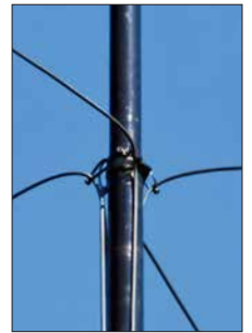
Bild 40: Führung der Koaxialkabel am Mast
