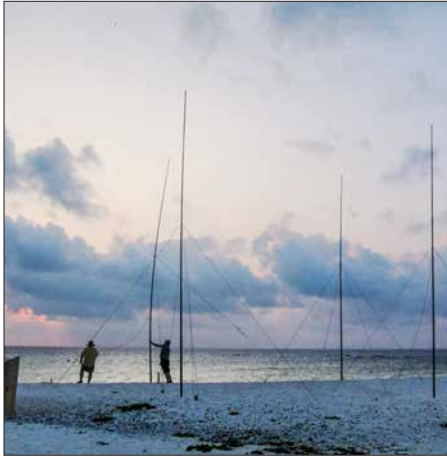
Dave, WJ2O, und Dietmar, DL3DXX (r.), errichten die letzte Vertikal des 4-Squares für 30 m.
