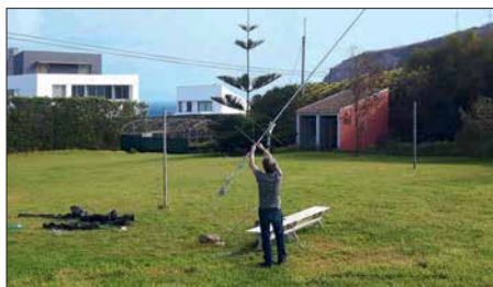
Frank, DH7FB, beim Aufbau der Kreuzyagi-Antennen für 2 m. Im Hintergrund ist der Atlantik zu sehen und rechts auf dem Felsen die Antennen der Contestgruppe CR2X. Foto: DF2ZC
