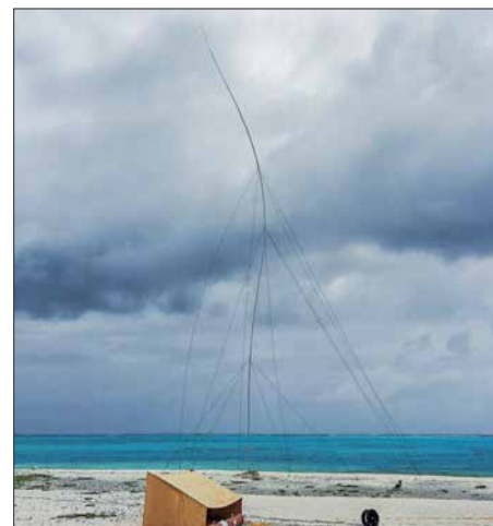
Unsere 27 m hohe Vertikal von Titanex für 160 m bog sich im aufziehenden Sturm.
