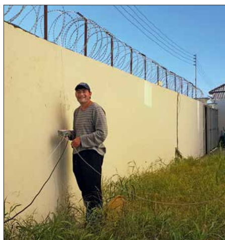
Adrian, KO8SCA, installiert hier die Radials unserer Vertikalantenne für das 80-m-Band.
