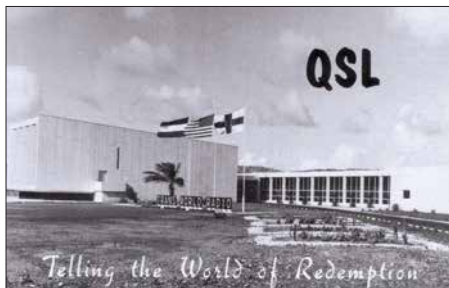
Stations- und Verwaltungsgebäude von TWR Bonaire QSLs: HKu
