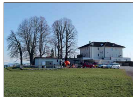
Antennenanlage von HB9NL auf dem Nollen Foto: HB9NL
