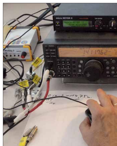
MicroHam-Interface am TS-570, improvisierte Verkabelung macht es möglich.
