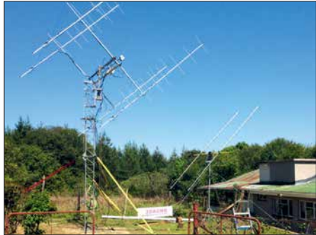
Links sieht man die 4×9/6-Element-Gruppe für 2 m, rechts die zwei 9-WL-M2-Yagis für 70 cm.
