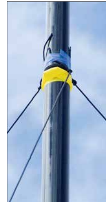
Bild 40: Führung der Koaxialkabel am Mast
