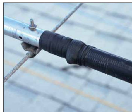
Reparierte Spule des 40-m-Beams
